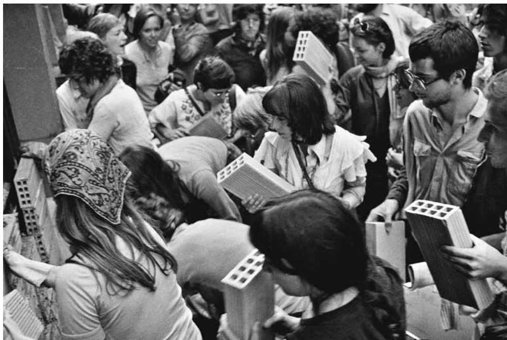
Suite à la démolition du local du Centre Femmes, murage de la porte de l'Administration municipale à l'Hôtel de Ville. Genève, 12 août 1976 (Interfoto).
