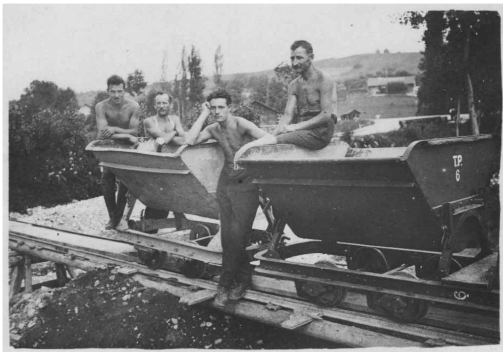
Perly: chantier de chômage, Lucien Tronchet, debout, et 3 collègues (1921). (Source: Collection Collège du travail, Genève)
